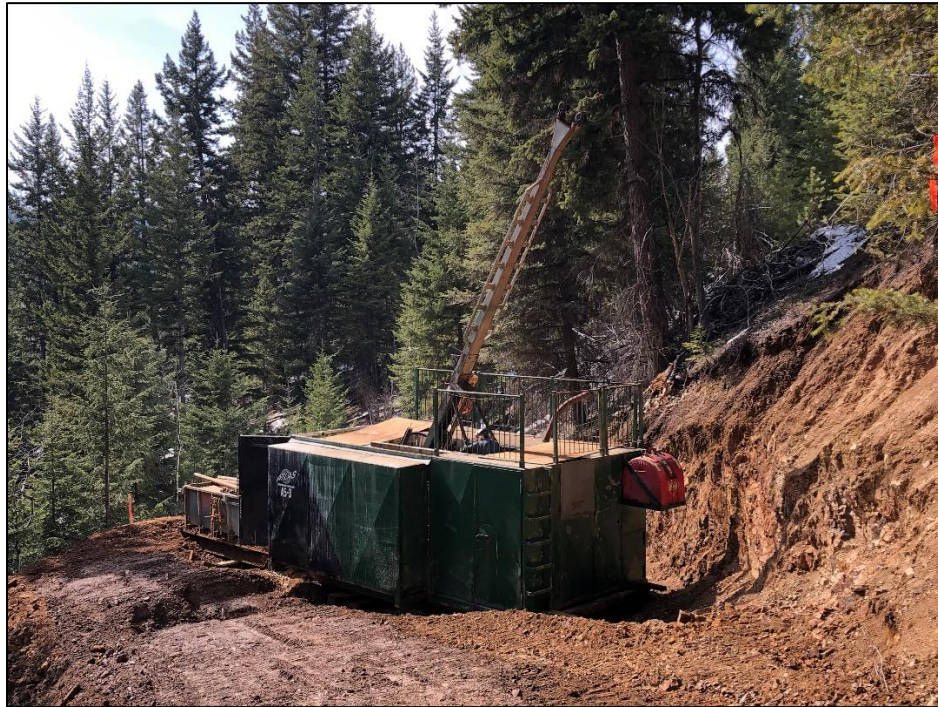
Abb. 2: Bohrungen 2021 in Zone Gate, MPD und Kernprotokollierungsanlage, Merritt (British Columbia)
